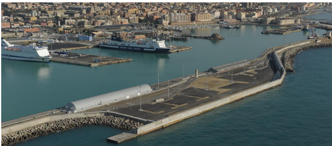
Figura 1: Antemurale Cristoforo Colombo, muro paraonde in primo piano
